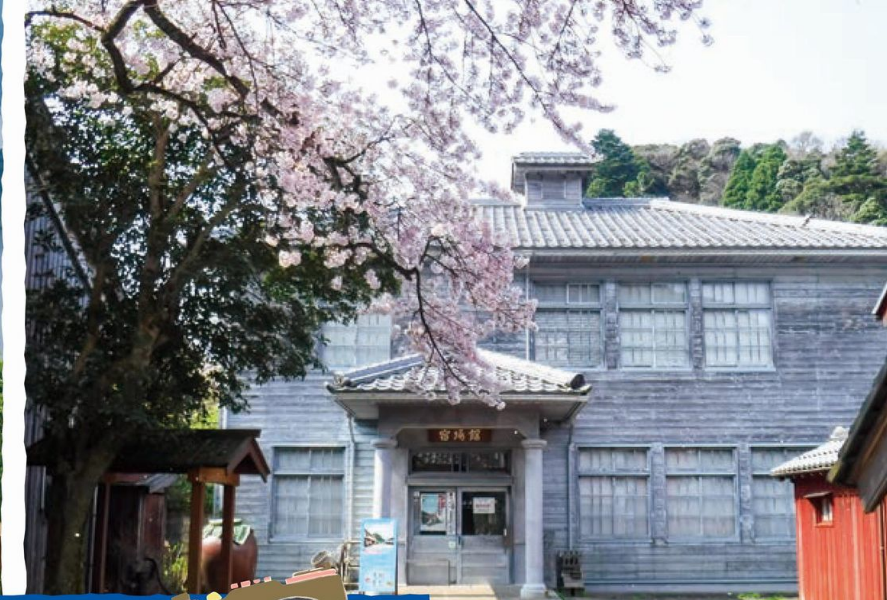
若狭鯖街道熊川宿資料館「宿場館」
